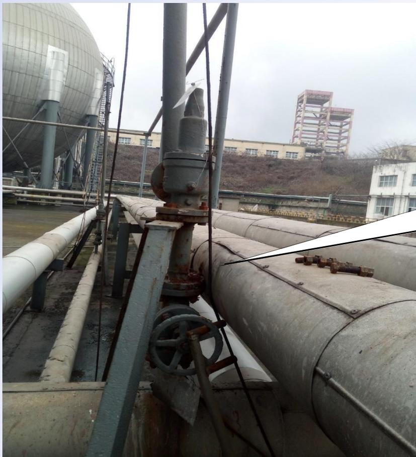
液氨球罐旁液氨管线安全阀上游阀关闭。安全阀排放口直接排放。
